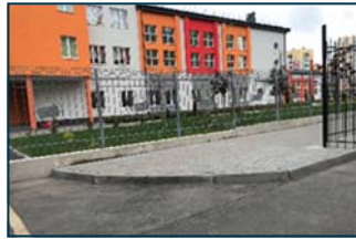
Комунальний заклад «Гімназія №24 Вінницької міської ради». м. Вінниця, Об'єкт «Великого будівництва»
