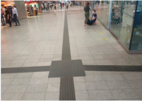
Приклад розміщення тактильних смуг у підземному переході
