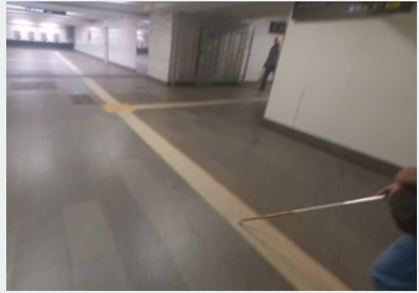
Приклад розміщення тактильних смуг у підземному переході
