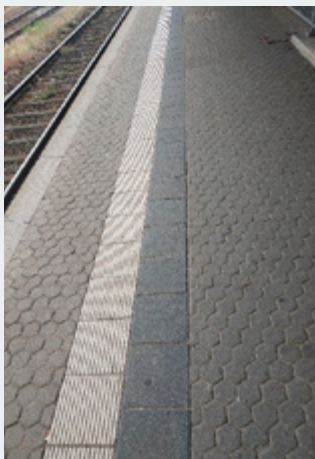
Тактильна смуга вздовж краю платформи. Тип рифу «поздовжні паралельні лінії»
