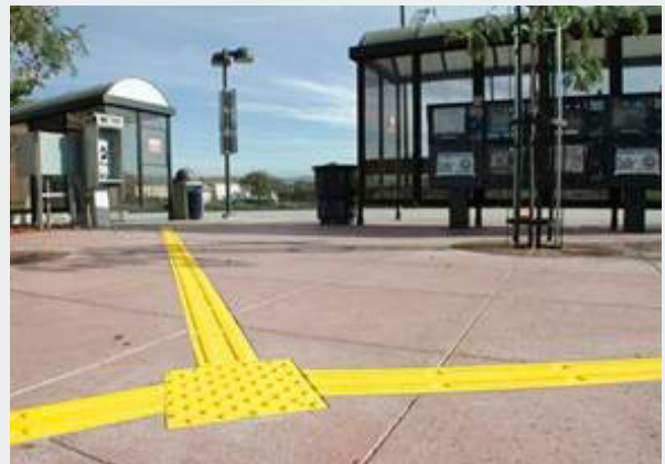
Системи тактильних смуг повинні бути передбачені по усіх шляхах руху на прилеглий території від входу на земельну ділянку до входів до об'єктів, будівель та споруд громадського призначення
