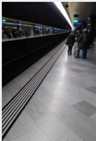
Тактильна смуга вздовж краю платформи. Тип рифу «поздовжні паралельні лінії»
