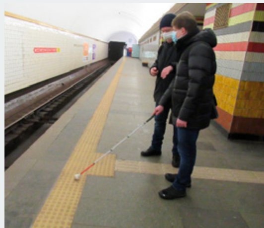
Тактильна смуга вздовж краю платформи. Тип рифу «зрізаний конус»
